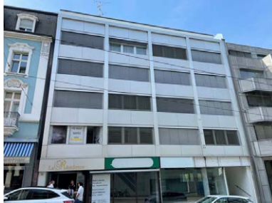
Basel, Binningerstrasse 7, Innere Margarethenstrasse 6
