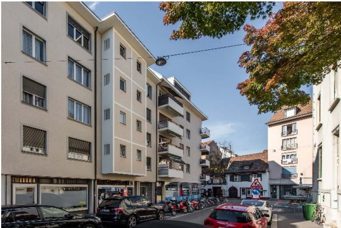
Liegenschaft Kirchgasse 2 mit Eingang zum Innenhof und Gebäude Nr. 2A.
