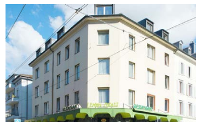
Zürich, Neptunstrasse 57 / Klosbachstrasse 44
