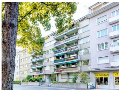
Basel, Riehenstrasse 157, Rosentalstrasse 50–52
