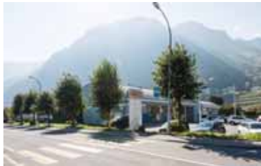
80. Vouvry, Chemin du Grand-Clos 1
