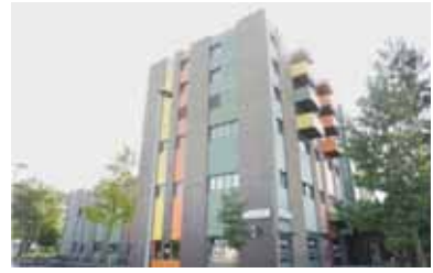
19. Delémont, Rue de l'Avenir 3
