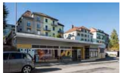
34. La Chaux-de-Fonds, Rue du Ravin 4
