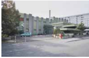
18. Delémont, Rue de l'Avenir 1
