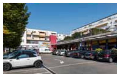
70. Saint-Prex, Rue de la Gare 1 – 13
