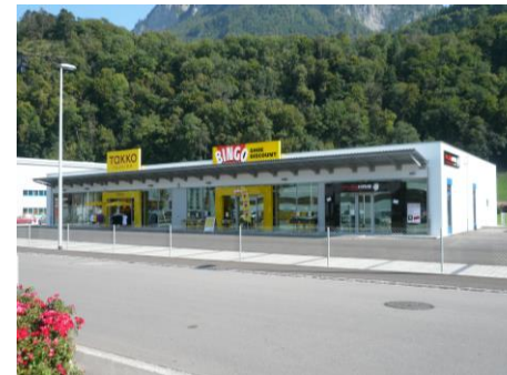
Ansicht Fassade Hauptstrasse vorher
