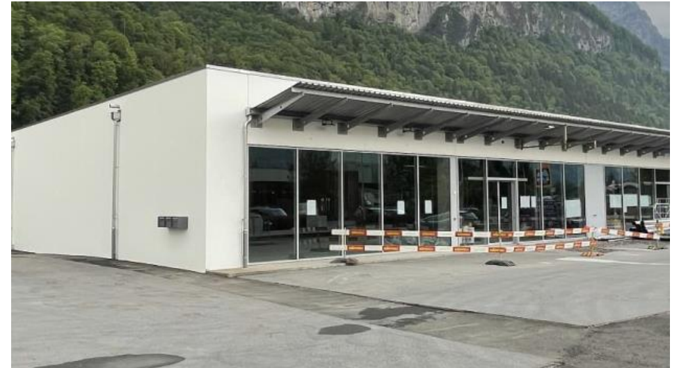
Ansicht Fassade Hauptstrasse (aktuell) für Migros
