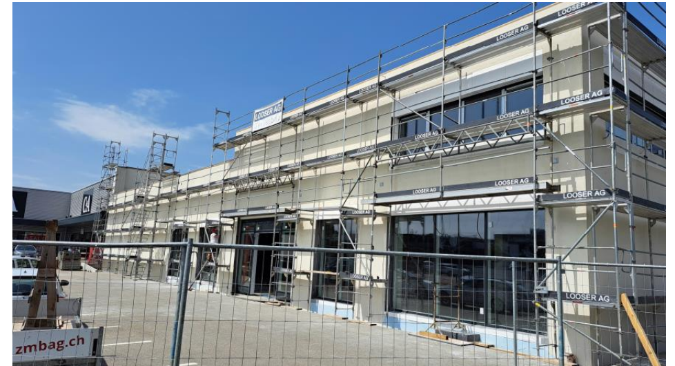
Hauptansicht mit neuem Eingang Müller Drogerie
