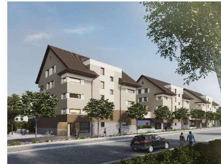
Neubauprojekt Flawil Nordfassade
