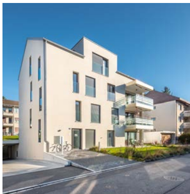
Tösstalstrasse 102/104 / Kreuzeggweg 23 Winterthur
