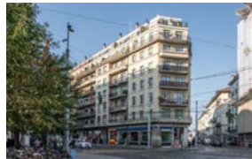
Genf, Rue des Deux-Ponts 18
