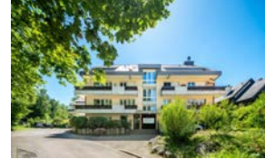
Zürich, Holderbachweg 21a
