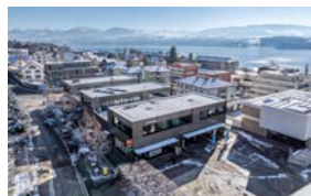
Männedorf, Alte Landstrasse 256 - 264
